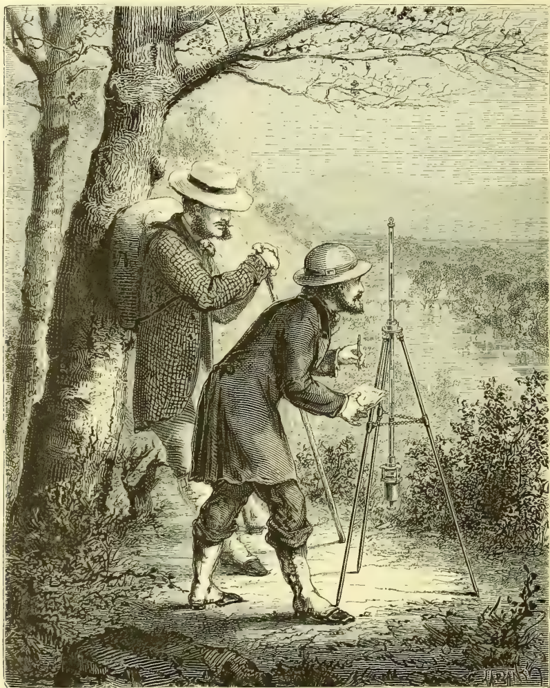
Fig. 63. — Le baromètre de Fortin; installation en voyage.
