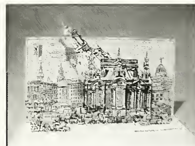
Wiederaufbau der Frauenkirche
