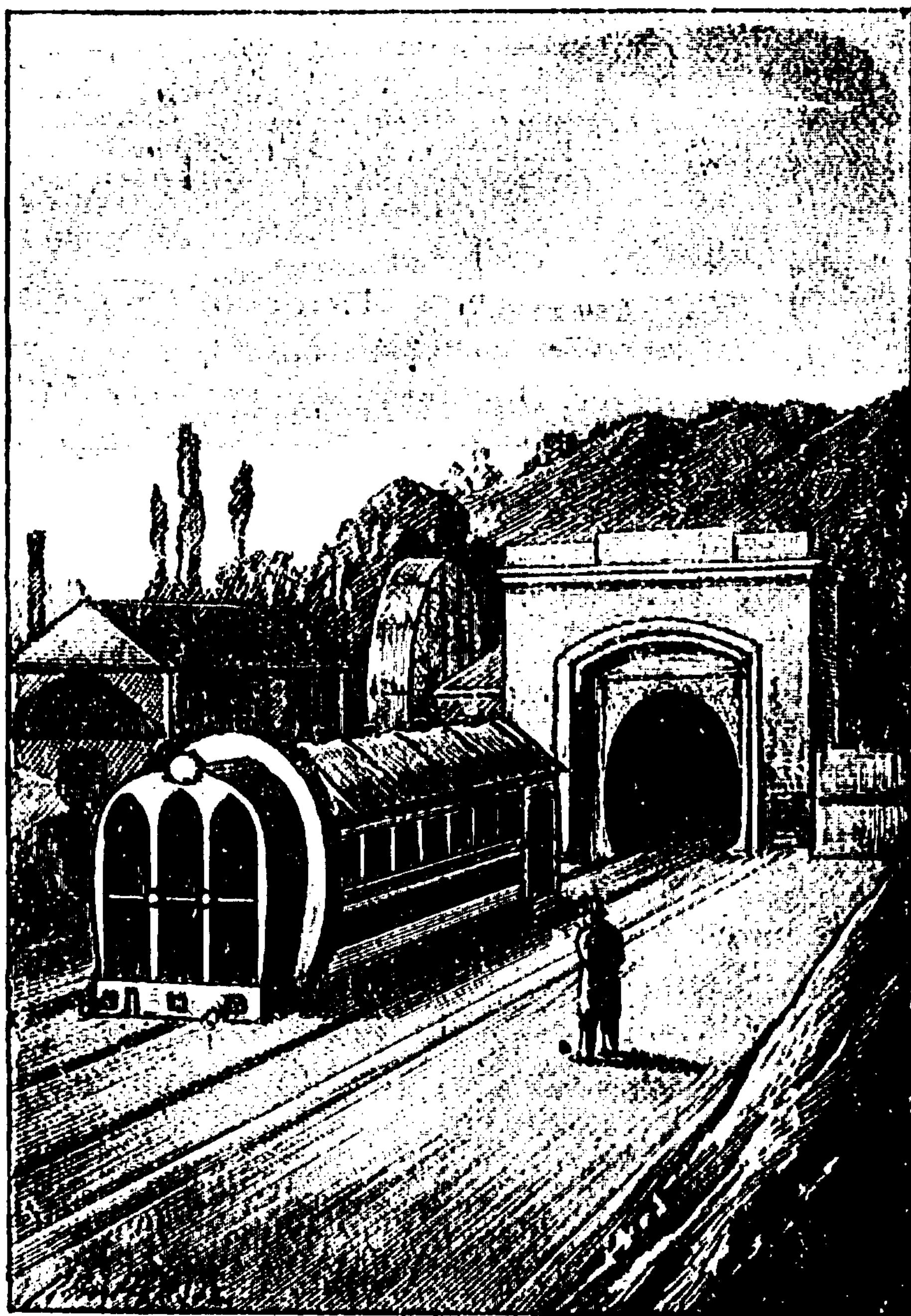
Fig. 143. — Essai de chemin de fer atmosphérique en Angleterre.
