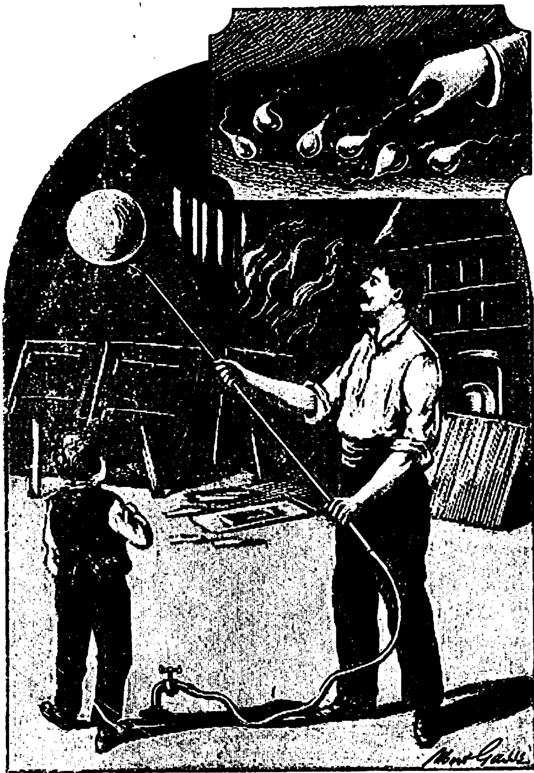
Fig. 171. — 1. Soufflage du verre à l'air comprimé. — 2. Les larmes bataviques.
