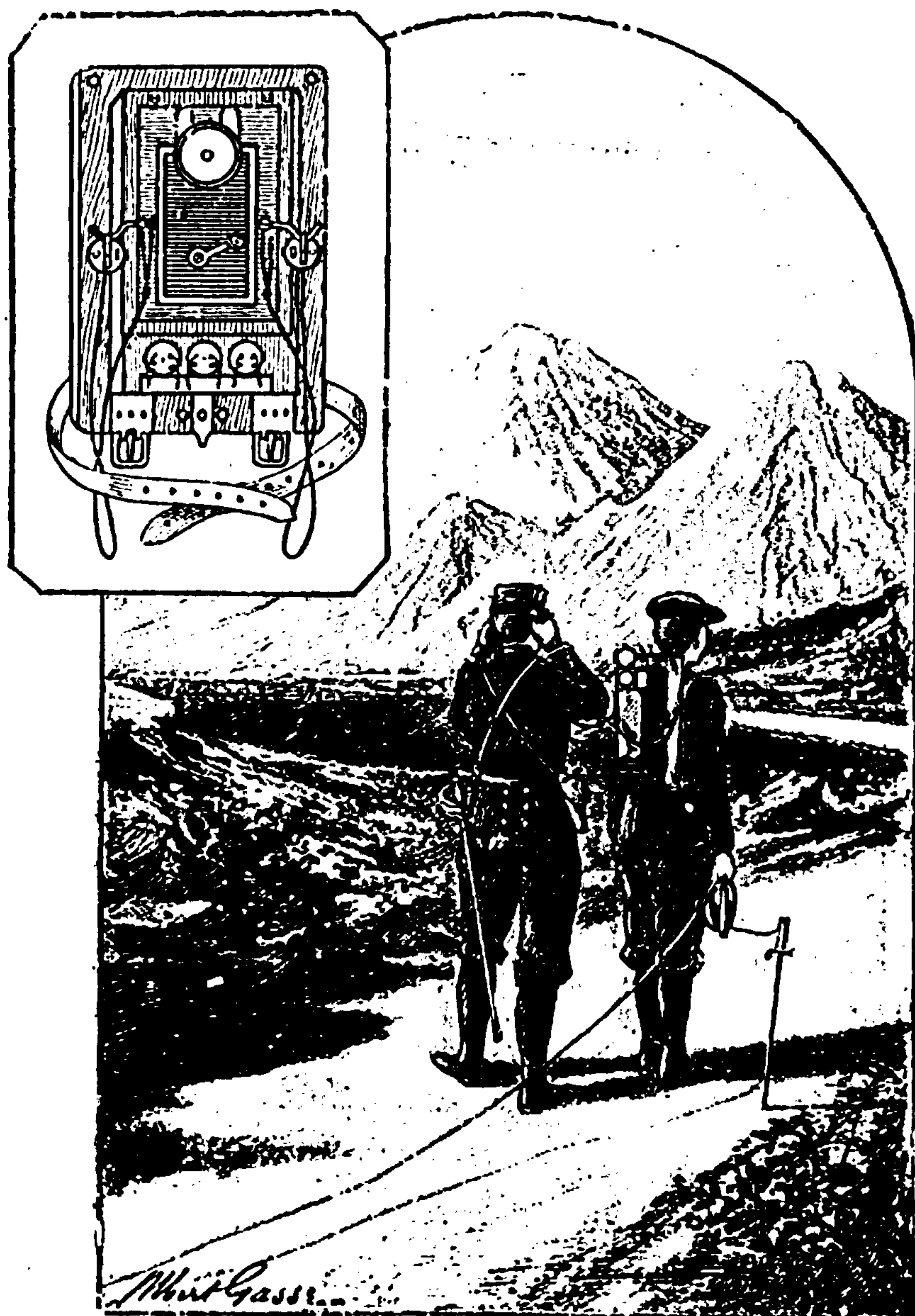
Fig. 83. — 1. Téléphone militaire système Charollois. — 2. Un poste téléphonique volant.
