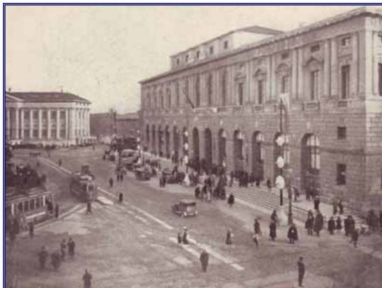
VEDUTA DELL'ESTERNO DELLA SEDE DEL CONGRESSO, IL GIORNO DELL'INAUGURAZIONE
